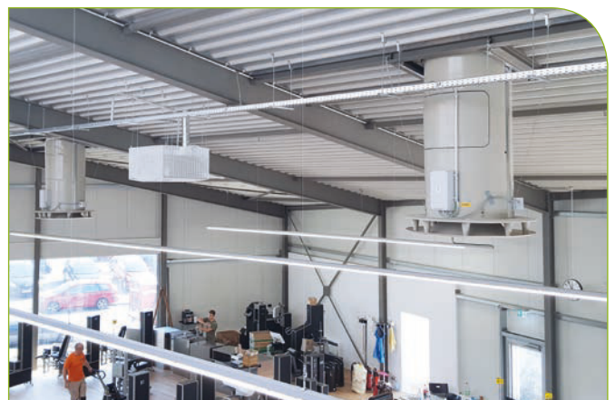
Abluftansaugung und Zuluft einbringung direkt unter der Hallendecke – durch große Zuluftwurfweite keine Kurzschlussgefahr
