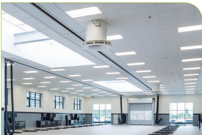
Abluftansaugung und Zuluft einbringung direkt unter der Hallendecke – durch große Zuluftwurfweite keine Kurzschlussgefahr
