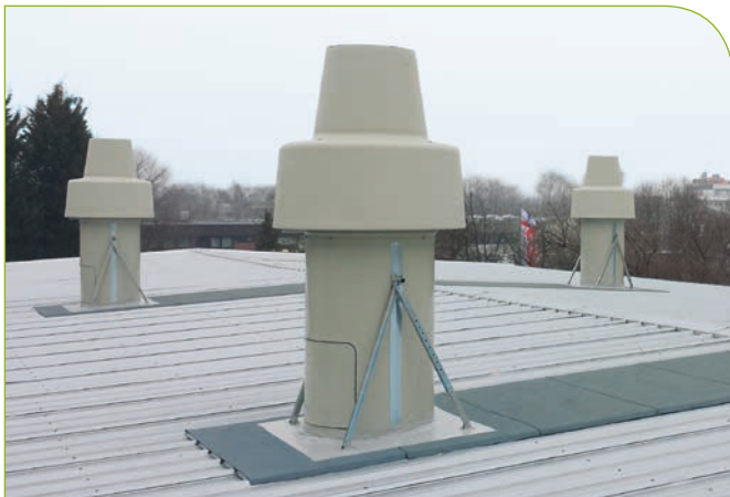
Der TX 3100A eingebaut im Hallendach
